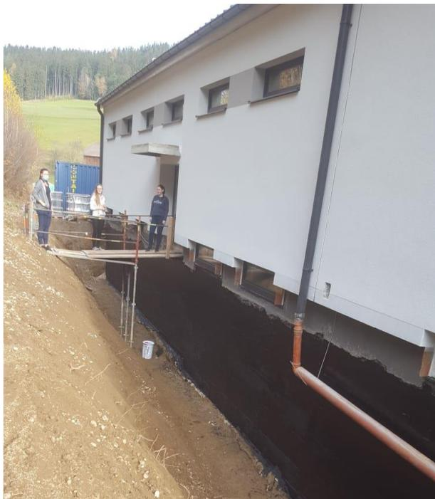
Im Zuge der thermischen Sanierung der Volksschule wurden durch die Baufirma weiters das hangseitige Mauerwerk trocken gelegt und die alte Holztüre nach Außen durch eine neue Fluchttüre ersetzt.
